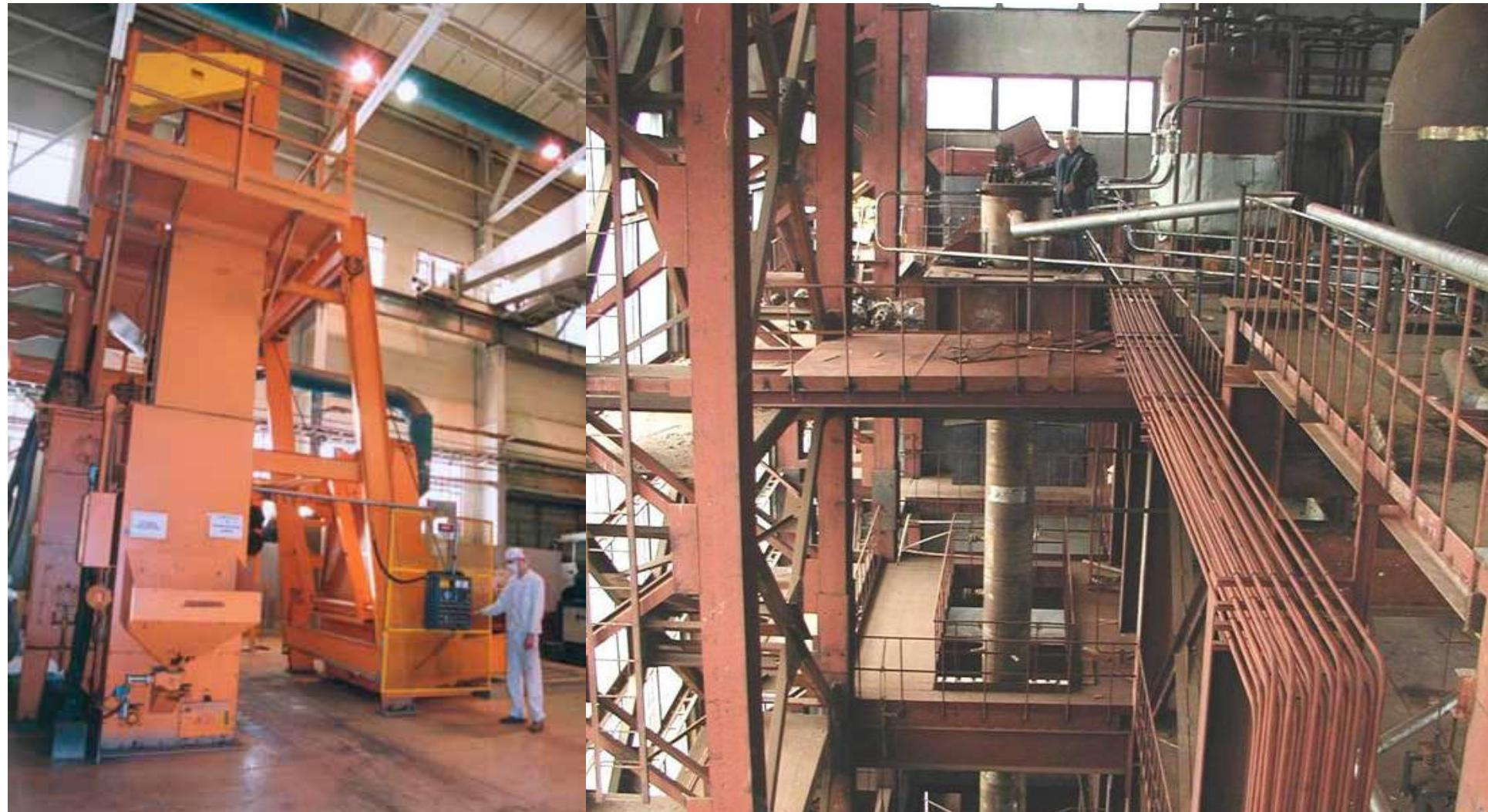
Они представляют собой трубопроводы, проложенные в радиационно-опасных помещениях, в которые, при необходимости, подается дезактивирующий раствор и с помощью пароэжекторного распылителя производится внешняя обмывка помещений и оборудования.
